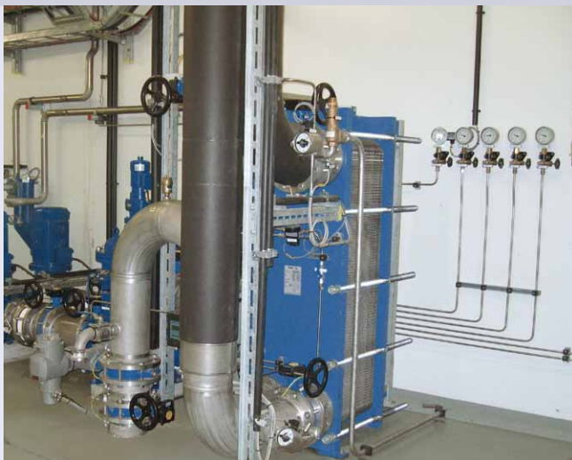
Охлаждение масла для гидросистем на электростанциях
