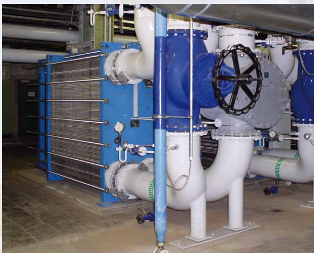
Охлаждение установок лазерной сварки в автомобильной промышленности
